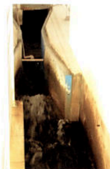
Figura 3: Ressalte do tanque da mistura rápida ou
