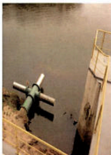
Figura 2. Crepina, aparelho responsável pela captação por meio de gravidade.
