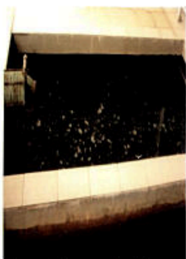
Figura 4. Tanque da mistura lenta ou floculação.
