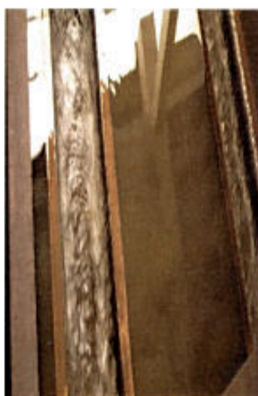
Figura 6. Tanque de filtração em processo de retrolavagem.
