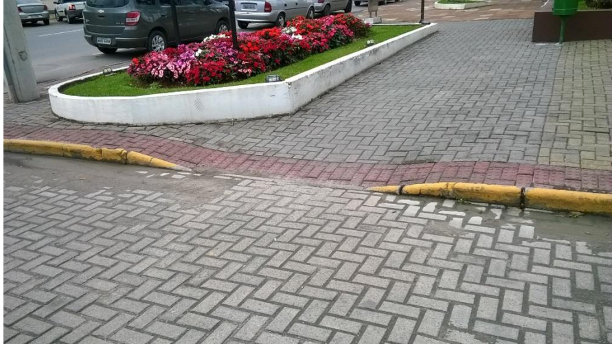
Figura 15 – Segunda rampa de acesso para cadeirantes
