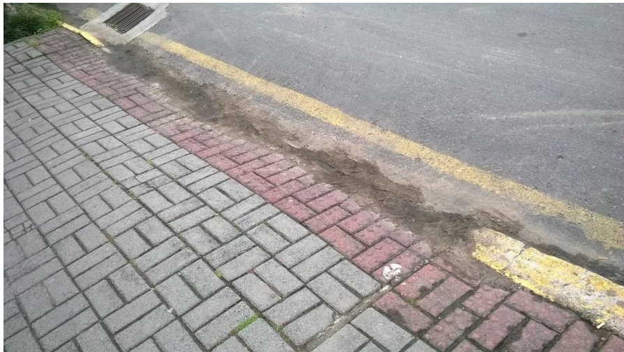
Figura 14 – Rampa de acesso para cadeirantes Getúlio Vargas
