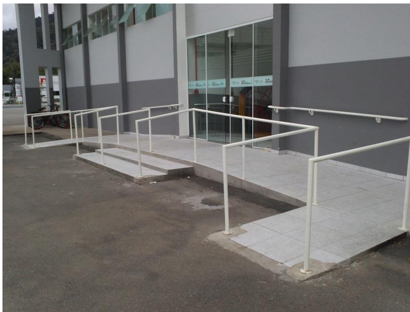
Figura 1 – Rampas e corrimões de acesso ao ginásio
