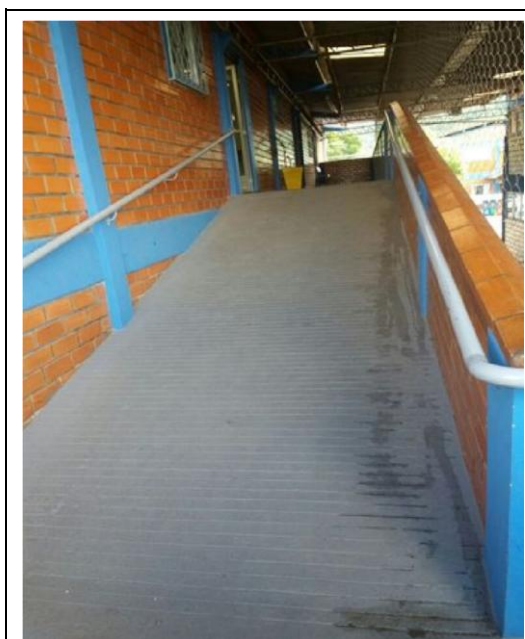
Rampa de acesso ao segundo andar
