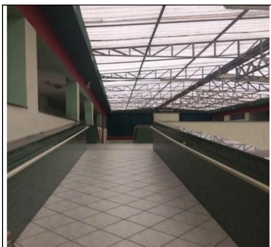
Corrimão da rampa de acesso ao segundo andar
