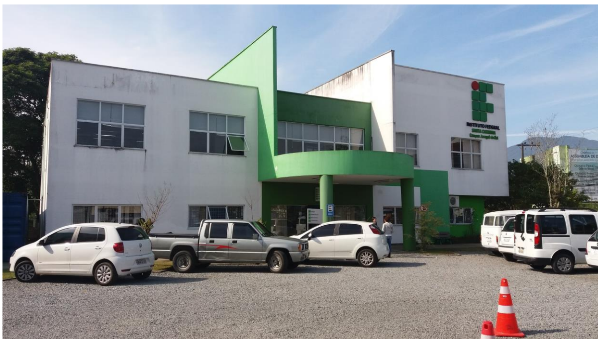
Figura 2: Bloco Administrativo IFSC - Câmpus Jaraguá do Sul – Centro em 2016
