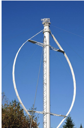
Figura 12 - Gerador eólico de eixo vertical
