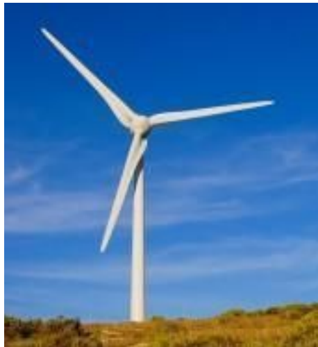
Figura 13 - Gerador eólico de eixo horizontal
