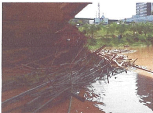
Figura 6 e 7 - Galhos presos aos alicerces da Ponte Abdon Batista.
