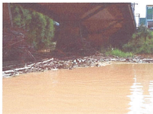
Figura 6 e 7 - Galhos presos aos alicerces da Ponte Abdon Batista.
