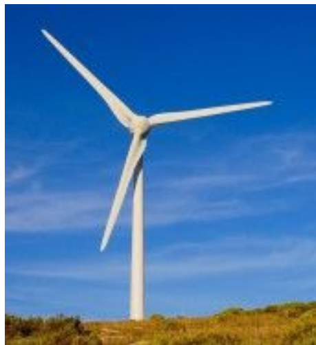
Figura 12: Gerador eólico de eixo horizontal.
