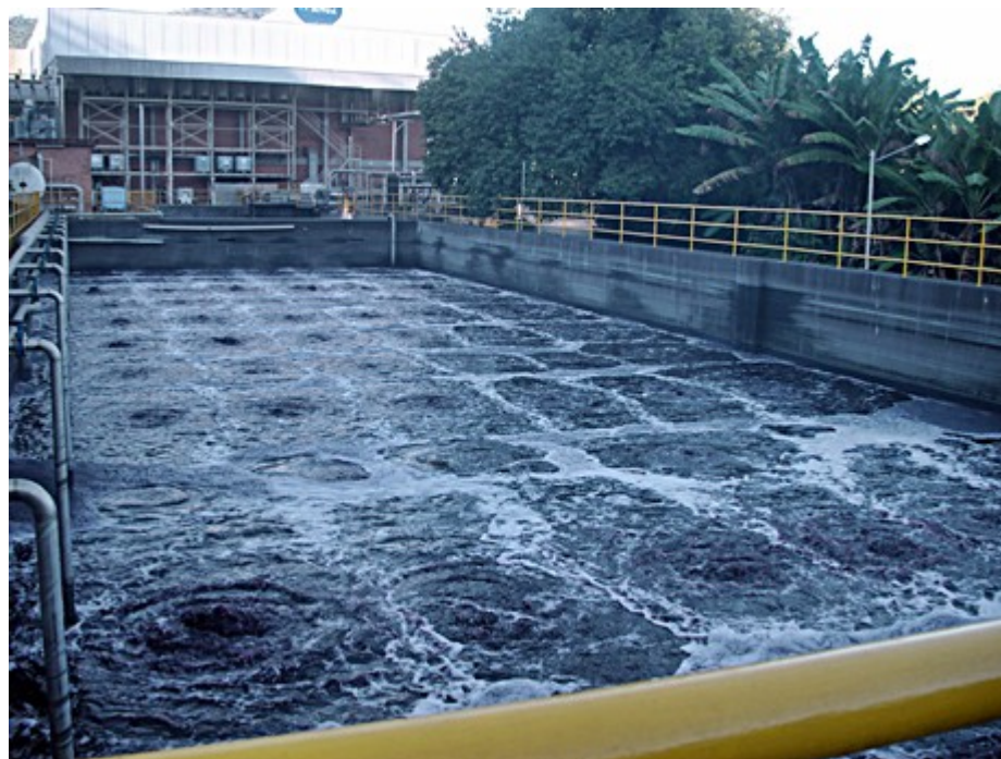
Imagem. 3 – Tanque de retenção
